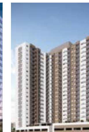
Vibra Estação Oratório
